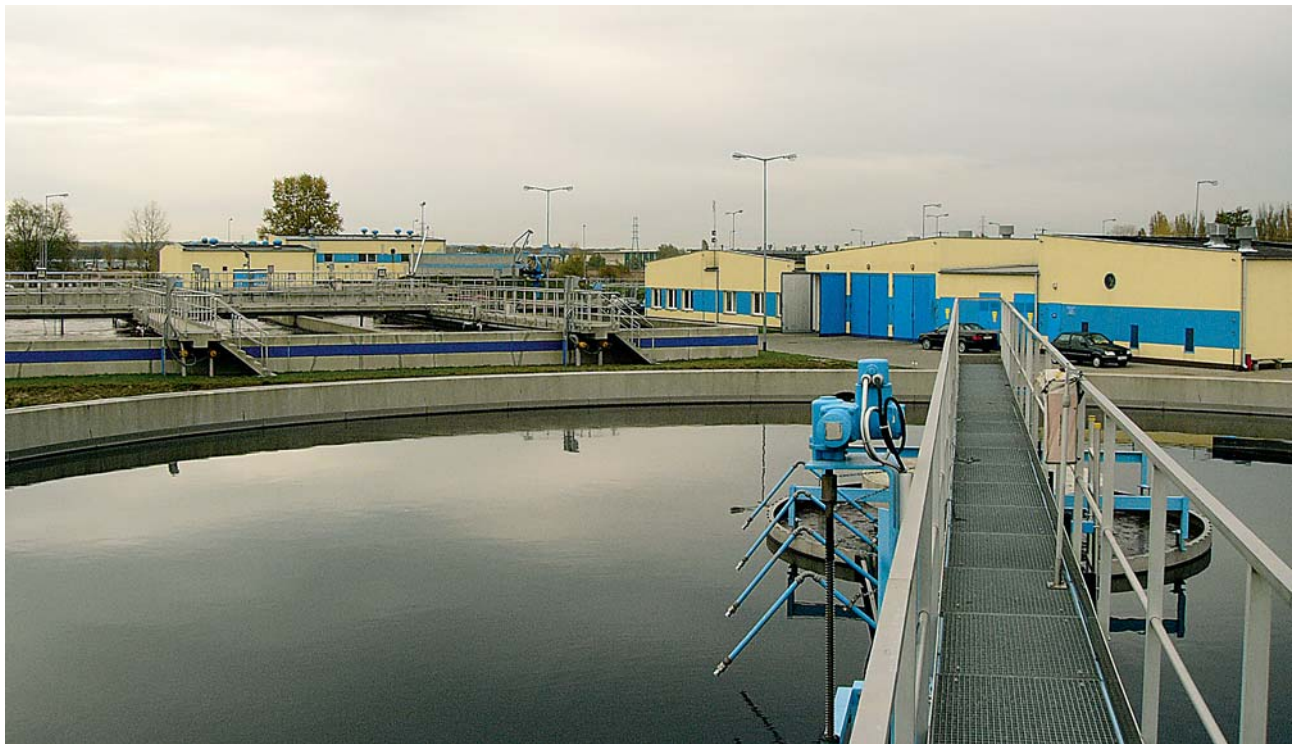
Mechaniczno-biologiczna oczyszczalnia ścieków w Kostrzynie (fot. Wojciech Jankowiak)
